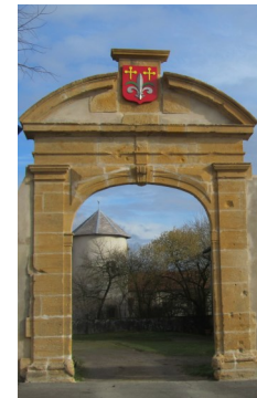
Portail cour du château
